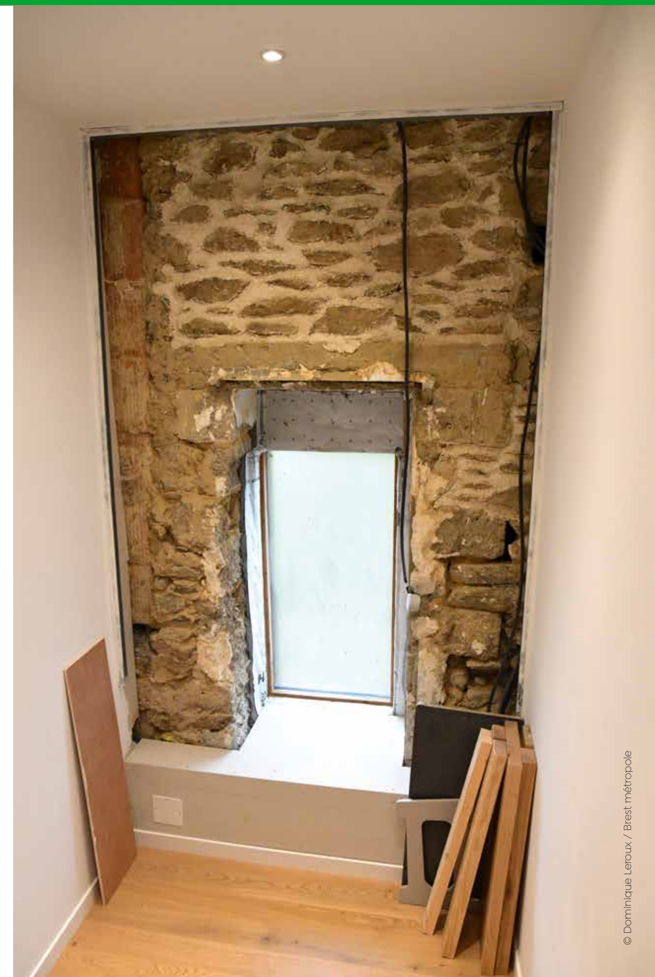
▲ Isolation des fenêtres
